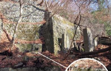
▲架線場跡。ここも三方が3段の石積みで囲まれている。その高さは、5m以上あるだろうか。写真右の辺りに、トロッコが横付けされ、鉱石が下ろされた。木が伸びており、中洲側の見通しは悪かった。
