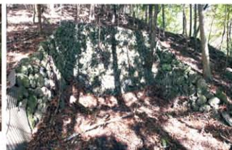
▲巻き上げの機械が設置されていた場所。山の斜面を切り取り、三方が石積みで囲まれている。
