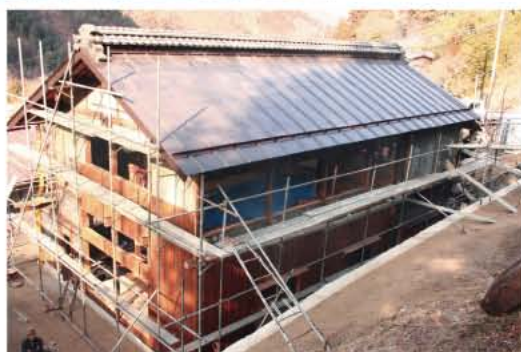
赤沢宿にある清水屋の改修工事風景。今にもつぶれそうだった建物を解体(写真右上)。元通りに組み立てられるよう、柱は番号をつけて保管(写真右下)。ほぞや継ぎ手など、昔の人の技術に感心する敏彦さん(写真中下)。壁は竹で小舞を組んで土を塗る(写真左上)。屋根の上には、立派な鬼瓦が再び備え付けられた(写真中上)。今年3月の状態(写真左下)。後は、外壁と建具、そして設備や内装の工事を残すのみ。
