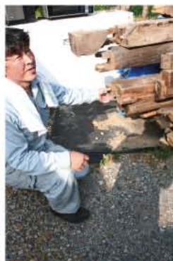
赤沢宿にある清水屋の改修工事風景。今にもつぶれそうだった建物を解体(写真右上)。元通りに組み立てられるよう、柱は番号をつけて保管(写真右下)。ほぞや継ぎ手など、昔の人の技術に感心する敏彦さん(写真中下)。壁は竹で小舞を組んで土を塗る(写真左上)。屋根の上には、立派な鬼瓦が再び備え付けられた(写真中上)。今年3月の状態(写真左下)。後は、外壁と建具、そして設備や内装の工事を残すのみ。
