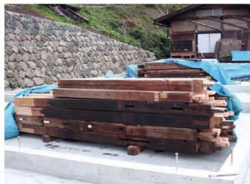
赤沢宿にある清水屋の改修工事風景。今にもつぶれそうだった建物を解体(写真右上)。元通りに組み立てられるよう、柱は番号をつけて保管(写真右下)。ほぞや継ぎ手など、昔の人の技術に感心する敏彦さん(写真中下)。壁は竹で小舞を組んで土を塗る(写真左上)。屋根の上には、立派な鬼瓦が再び備え付けられた(写真中上)。今年3月の状態(写真左下)。後は、外壁と建具、そして設備や内装の工事を残すのみ。
