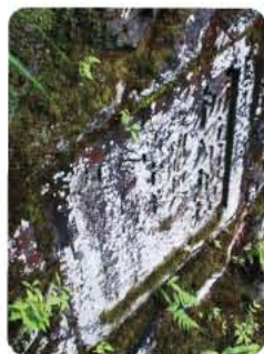
本堰堤の左上には、プレートが。読みづらいが「栃原堰堤 昭和八年竣工」と彫ってある。
