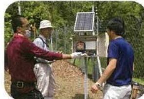
電気柵の補修(左・右)と、周辺の草刈り(上)。 電線に蔓などが絡んで漏電したり、たるんだ電線が金属部分に接触してショートしたりしないよう、メンテナンスが必要だ。
