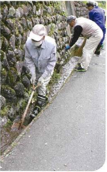
集落内の側溝清掃。壁面に生えるコケや雑草もスコップで除去する。 浚った泥や落ち葉・雑草などは箕(み)とトラックで運んで捨てる。
