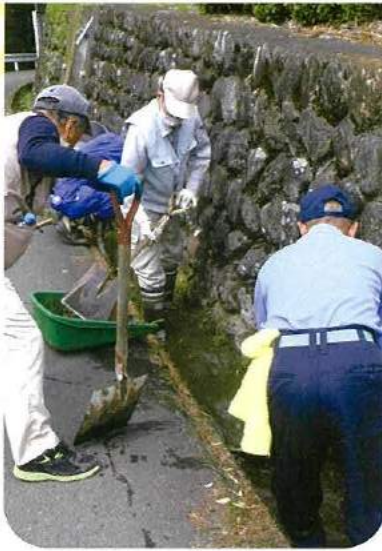
集落内の側溝清掃。壁面に生えるコケや雑草もスコップで除去する。 浚った泥や落ち葉・雑草などは箕(み)とトラックで運んで捨てる。
