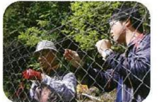
電気柵の補修(左・右)と、周辺の草刈り(上)。 電線に蔓などが絡んで漏電したり、たるんだ電線が金属部分に接触してショートしたりしないよう、メンテナンスが必要だ。
