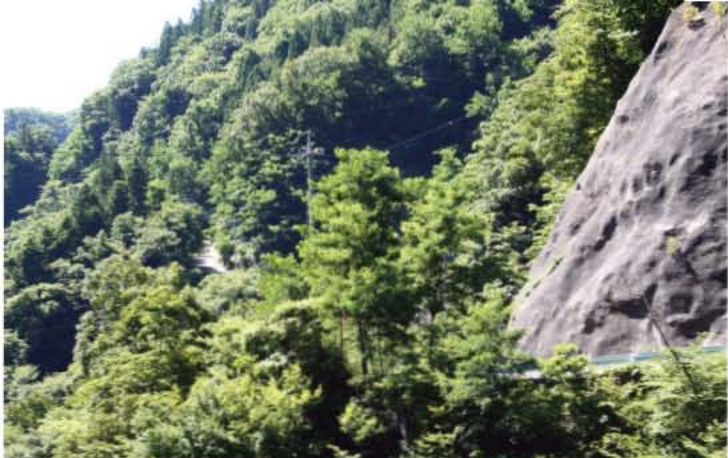
町境の遅喰沢(おそくいざわ)から、早川町方面を見る。右手のがけは、崩落防止のためコンクリートでがっちり固められている。
