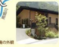
板面庵の外観
